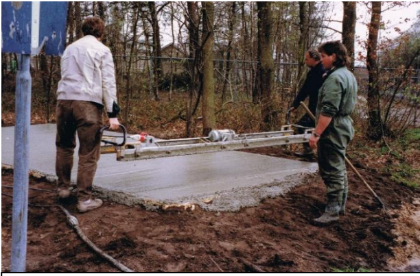
De grondplaat wordt gereed gemaakt
