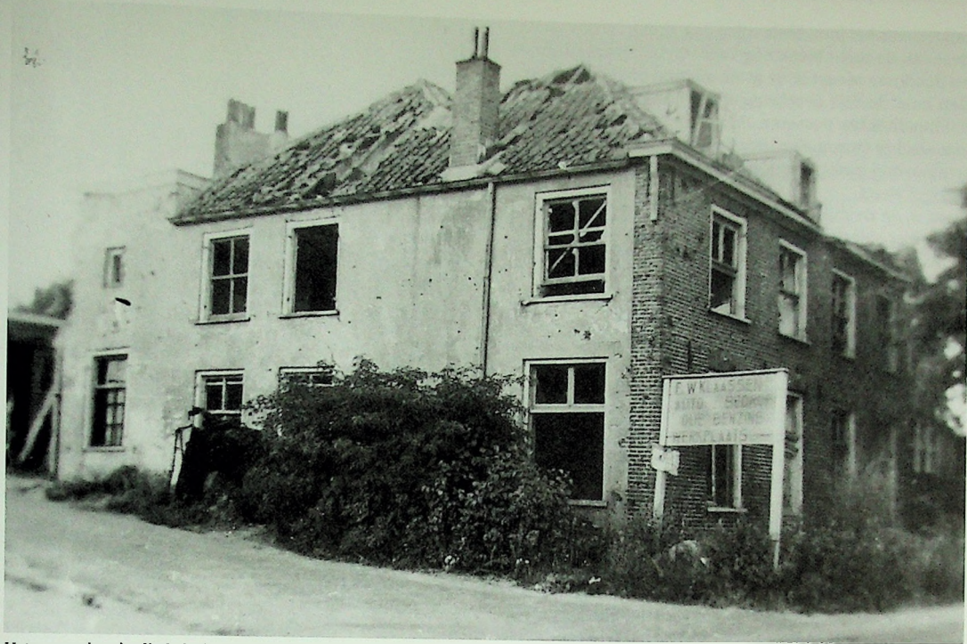
Het zwaar beschadigde huis van de familie Breman aan de Benedendorpsweg in Oosterbeek in 1945. (Foto collectie Gelders Archief)
