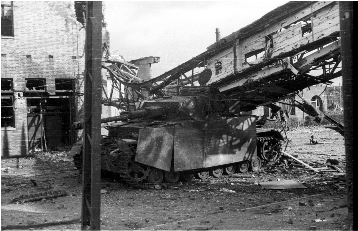
Figuur 7 Foto van de PzIV Ausf.H zoals hij is gezien door Jan Meijer op zaterdag 23 september 1944 (Ministory 93, p4). De pijpbrug van de CAMIZ ligt geknakt op het achterdek van de uitgebrande tank. (Bron:1533-387, GA)
