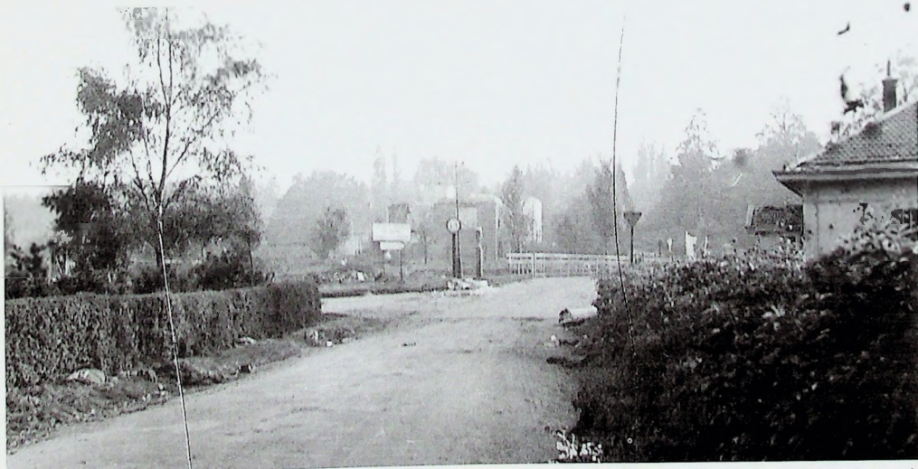
De kruising Dreyenseweg en Van Limburg Stirumweg (links), gezien vanuit het noorden (in de richting van de brug over de spoorlijn Utrecht-Arnhem). Rechts het pand Dreyenseweg 2-4, waar onder meer de familie Kalle woont. In het midden, op de achtergrond, het uitgebrande pension van Aalbers (Stationsweg 53), dat op 19 september 1944 in vlammen opging. Rechts van de Dreyenseweg, en ook nabij de genoemde kruising, is een bevoorradingscontainer neergekomen. Links, in de berm, drie lijken van Britse militairen. Rechts ligt ook een stoffelijk overschot van een geallieerde soldaat. De foto werd waarschijnlijk gemaakt in de periode 20-23 september 1944, door een cameraman van de Kriegsmarine. (foto Bundesarchiv, Koblenz)
