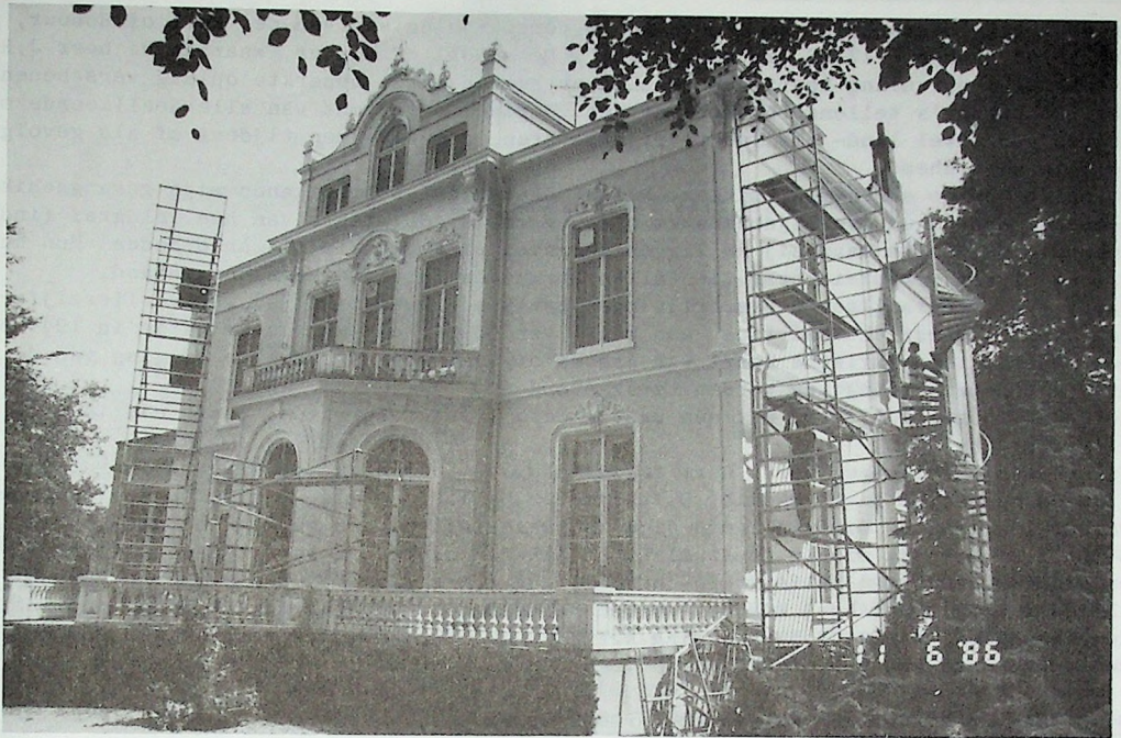
Huize Hartenstein in de steigers tijdens het schilderen van de buitenmuren. (foto: B.de Reus)
